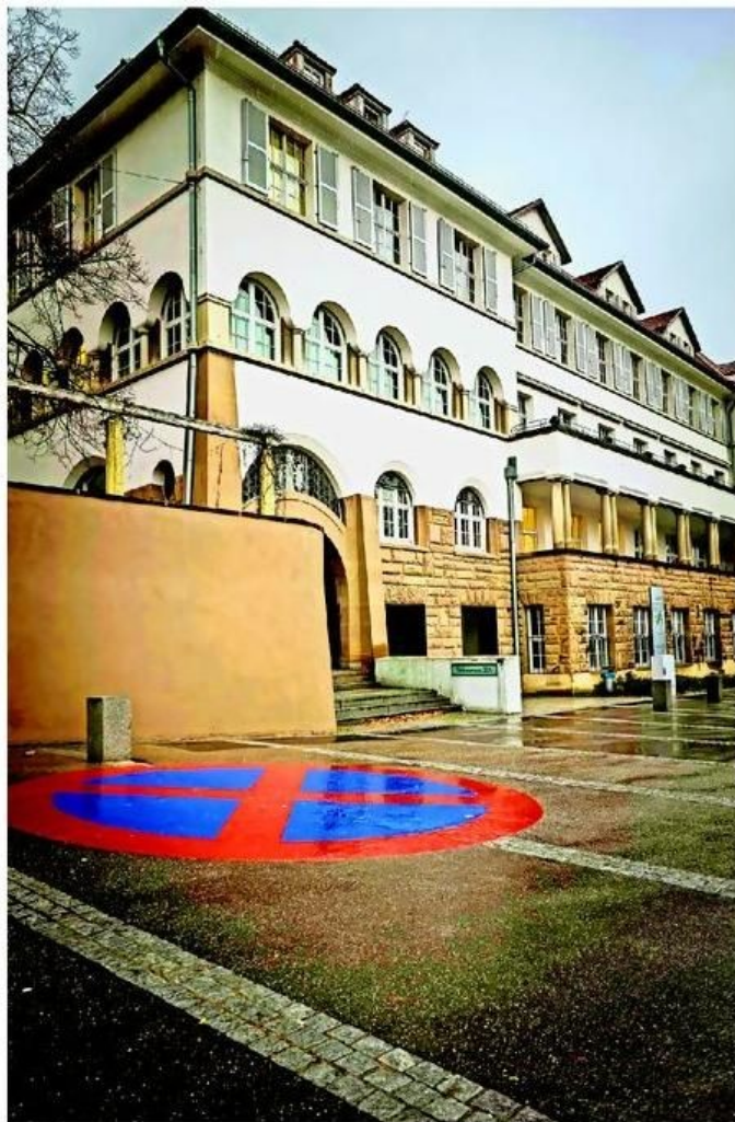
Das Gebäude Türlestraße 22 diente während der NS-Zeit als Kinderklinik. Bis zu 52 behinderte Jungen und Mädchen könnten dort umgebracht worden sein. Foto: Lichtgut/Max Kovalenko
