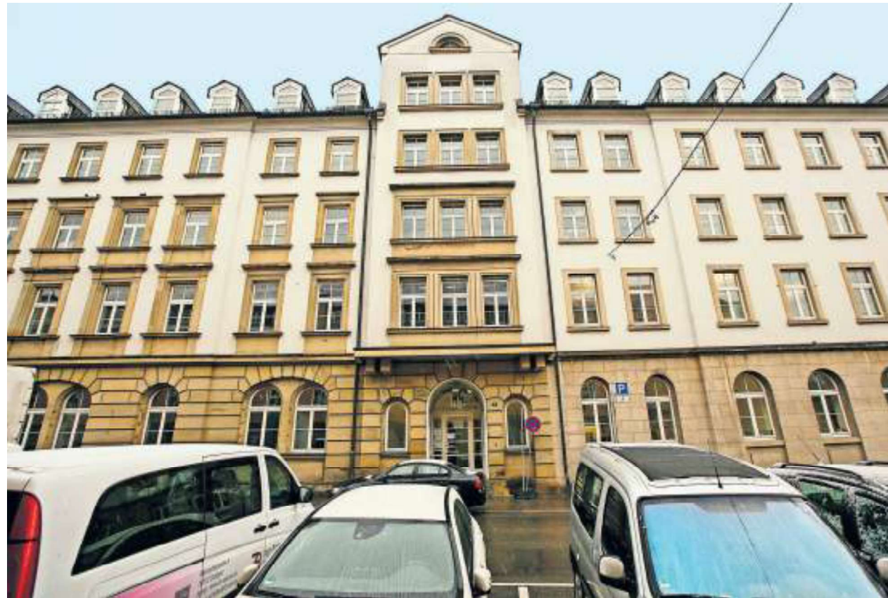
Das ehemalige Gestapo-Gefängnis Hotel Silber wird zu einem Lern- und Erinnerungsort umgebaut.
