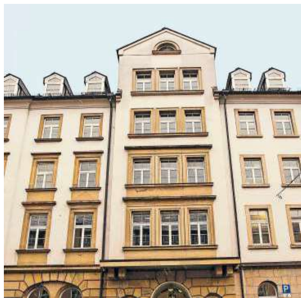
Im Hotel Silber saß früher die Gestapo. Das Frühstückszimmer (rechts bei der Unterzeichnung der Verträge) wird zum Foyer und Veranstaltungsort umgebaut.
